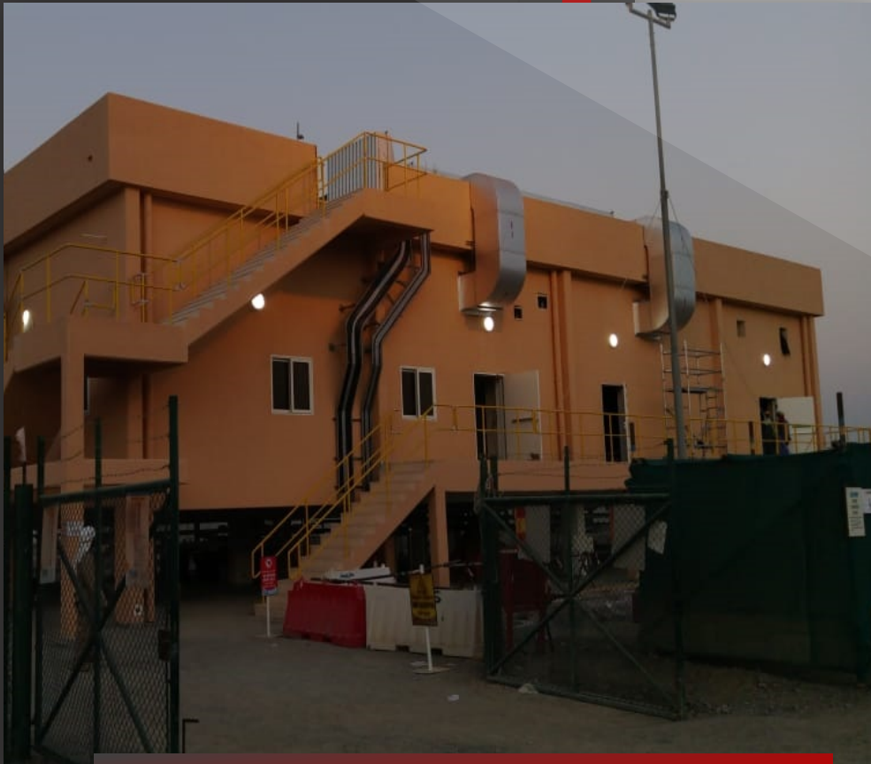
MEP Works – SIE GSS Project 2019
