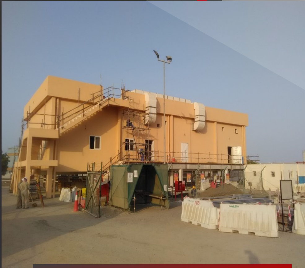
MEP Works – SIE GSS Project 2019
